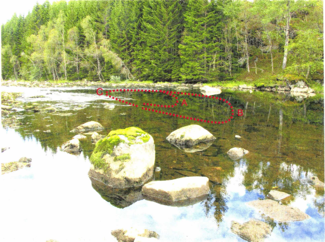
Fig. 1. Steinfyllinga i A bør spissast oppover og bør ikkje leggjast høgare enn kva elvebotnen var for 5 år sidan. Steinfyllinga bør oppstraums A skråne ned til eksisterande botn i B. Også nedstraums pkt. A bør steinfyllinga skråne ned mot elvebotnen i retning C.
